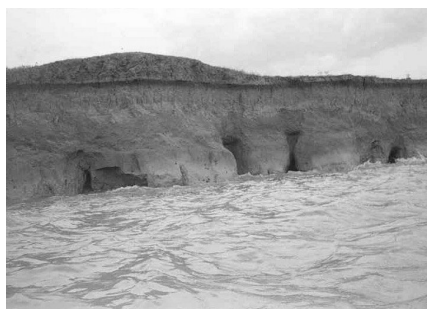
Рис. 1. Абразионные берега Каркинитского залива
